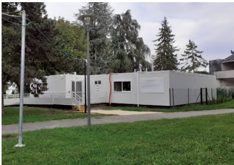
Installation de la maison médicale dans les modules
