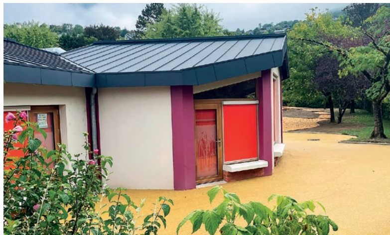
Les abords extérieurs de l'école maternelle terminés pour la rentrée
