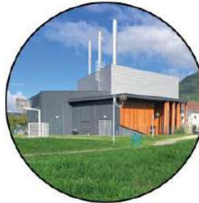
La nouvelle chaufferie
