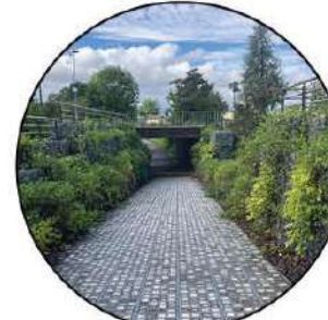
Accès piétons souterrain en liaison avec le centre
