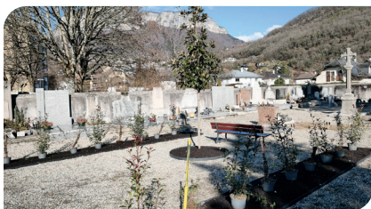
JANVIER - Travaux dans le vieux cimetière
