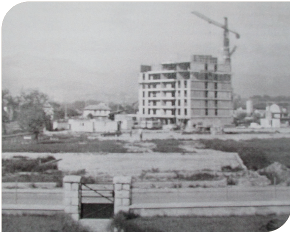
Construction du Clos Besson
