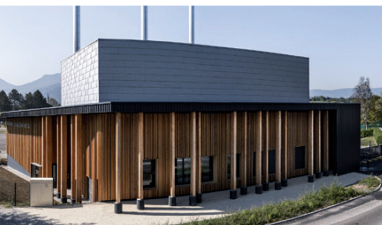
La chaufferie bois
