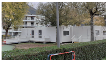
Les bâtiments modulaires sur le site des Mouettes
