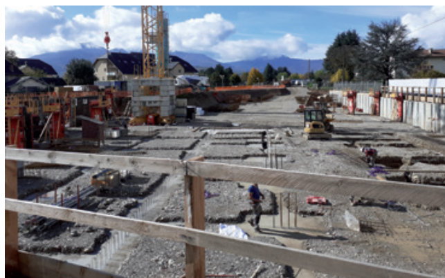
Les travaux du Centre Bourg sont lancés
