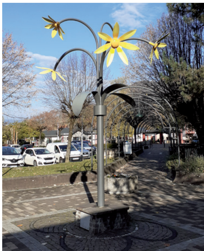
Les lampadaires rénovés du centre commercial
