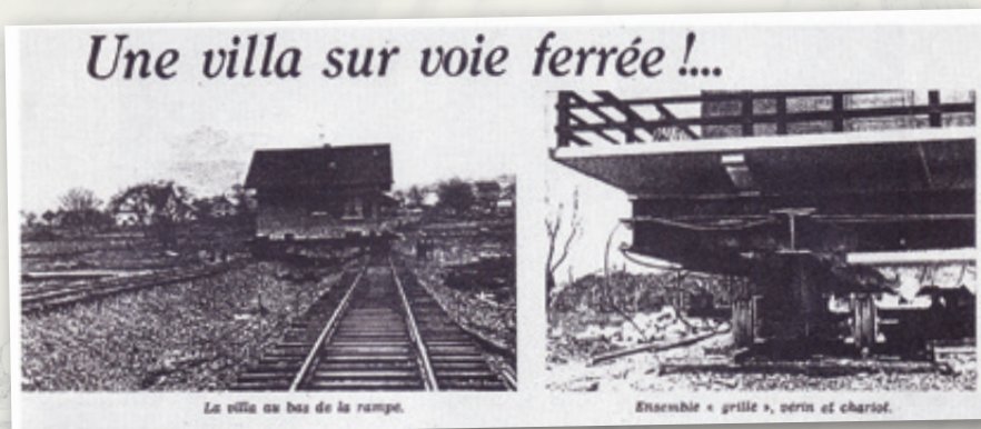
Le déplacement de 3 villas à l'automne 1968 en vue de la réalisation du Clos Besson
