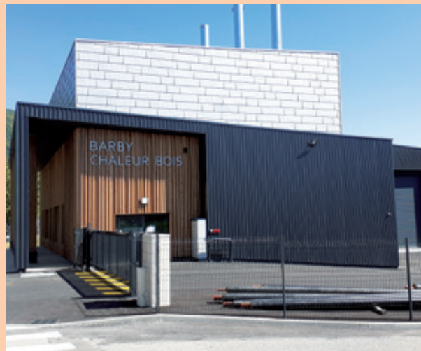
La chaufferie «BARBY CHALEUR BOIS»
