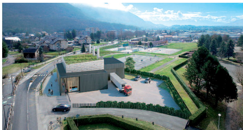
Chaufferie du réseau de chaleur
