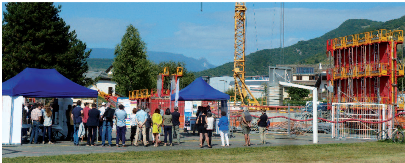
L'avancée des travaux et la pose de la 1ère pierre
