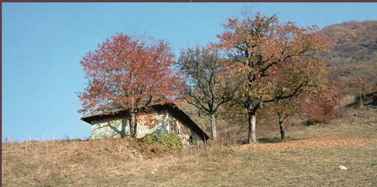
Ancien cellier des Hospices avant l'incendie malveillant
