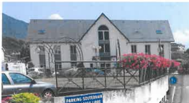
La Maison des Associations L'Envolée (ancienne « Ecole Blanche ») : un bâtiment emblématique à valoriser en façade nord
