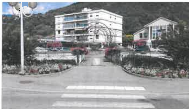
Dessus – Lien piéton central par passerelle étroite : fonctionnalité et valorisation insuffisantes et perspective sur façade Mairie : effet pesant du mobilier et signalétique
