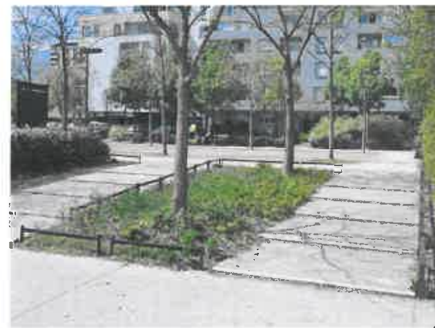
Pas d'âne en circulation piétonne, Ville de Lyon (69)
