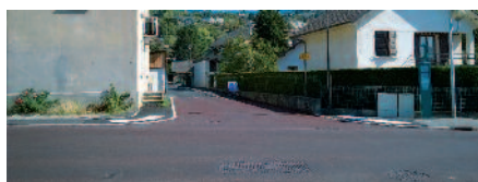
Aménagement du chemin de Casselagnat
