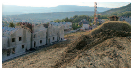
Avancement des travaux au Grand Clos
