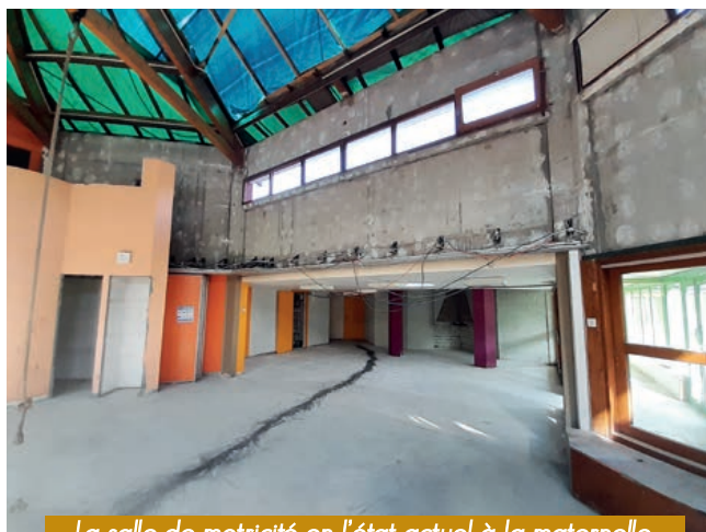
La salle de motricité en l'état actuel à la maternelle.
