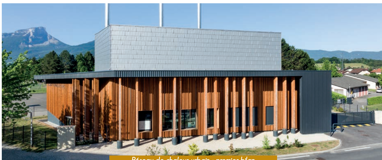
Réseau de chaleur urbain : premier bilan
