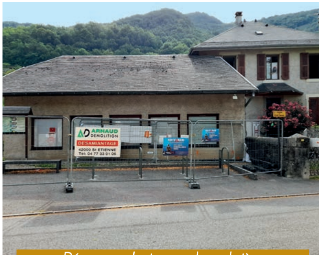
Démarrage des travaux du presbytère.
