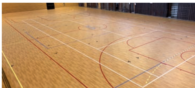
Le nouveau revêtement en cours de pose
